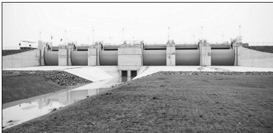
3. ábra. A beregi árapasztó tározó 6 darab szegmenstáblából álló beeresztő műtárgya Tarpa és Tivadar között (Forrás: MTI / Balázs Attila)
