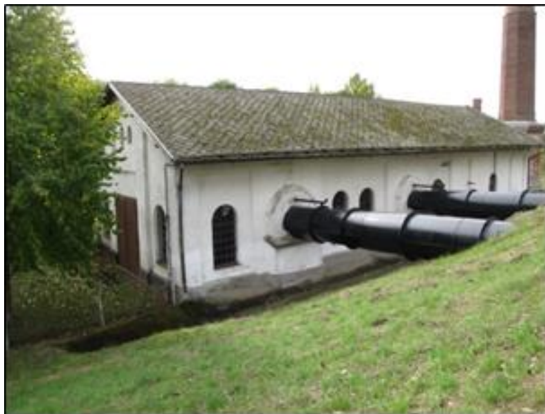
2. fénykép A Tiszaberceli I. szivattyútelep a tiszai töltés felől (Fotó: Konecsny K. 2016)
