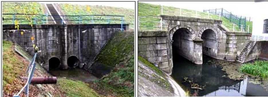
5-6. fénykép Az 1898-ban épült Olcsvai zsilip (bal) és Nagyecsedli zsilip jelenlegi képe (jobb) felől nézve
